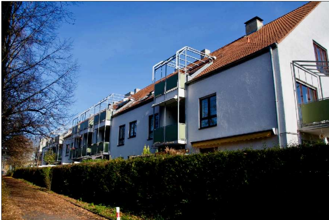
Foto 3 Ansicht von Westen
