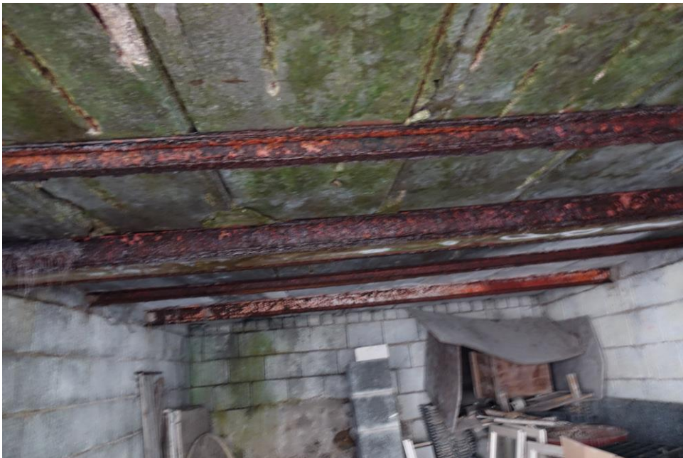
Bild 4: Stahlträger im Kellerraum stark korrodiert
