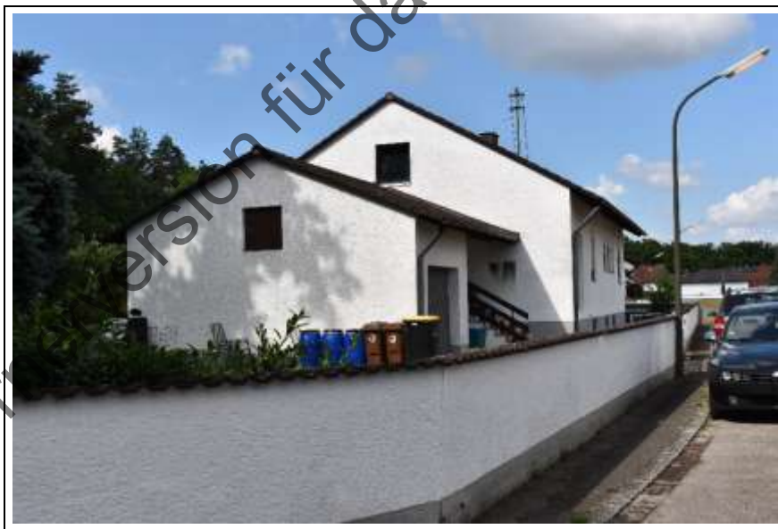
Foto 6: Straßenansicht von Nordost
