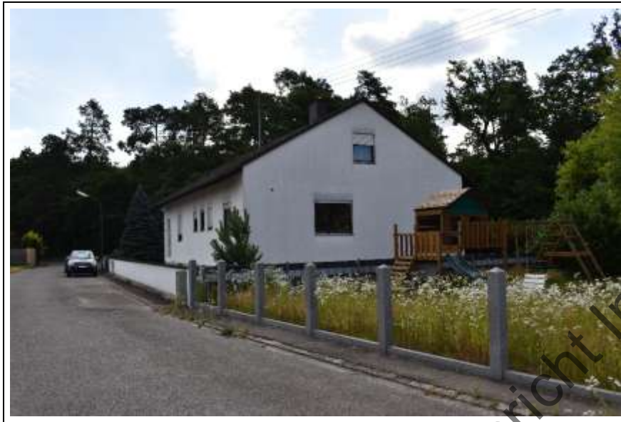
Foto 1: Straßenansicht von West
