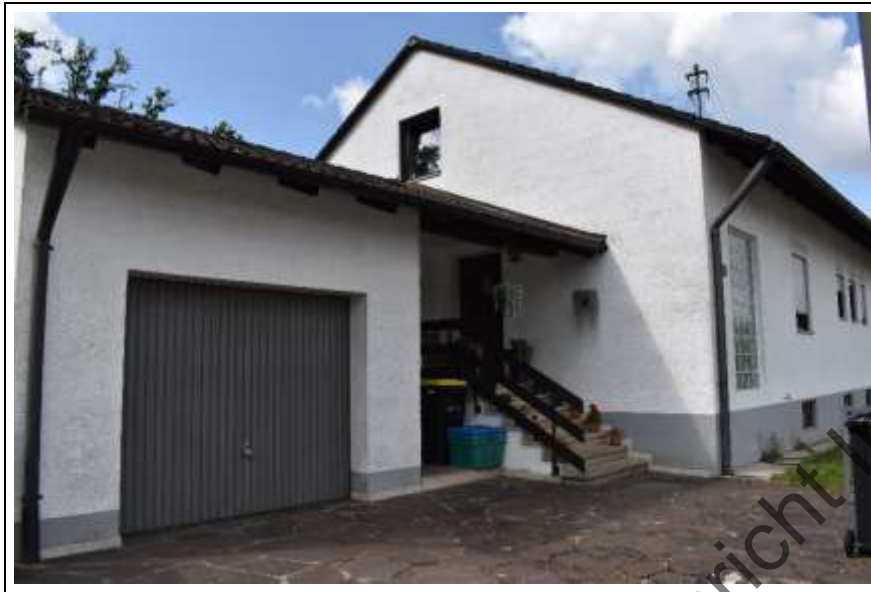
Foto 5: Straßenansicht von Nordost
