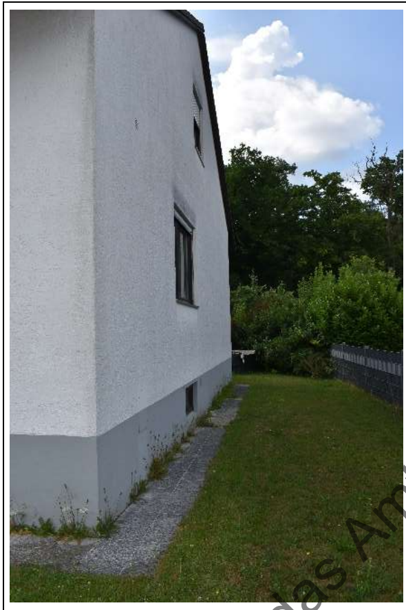
Foto 3: Straßenseiteansicht von Nord
