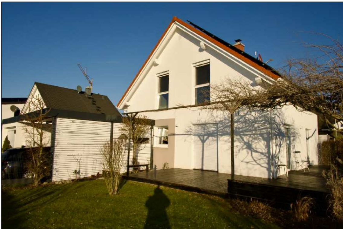
Foto 2 Ansicht von Süd-Westen
