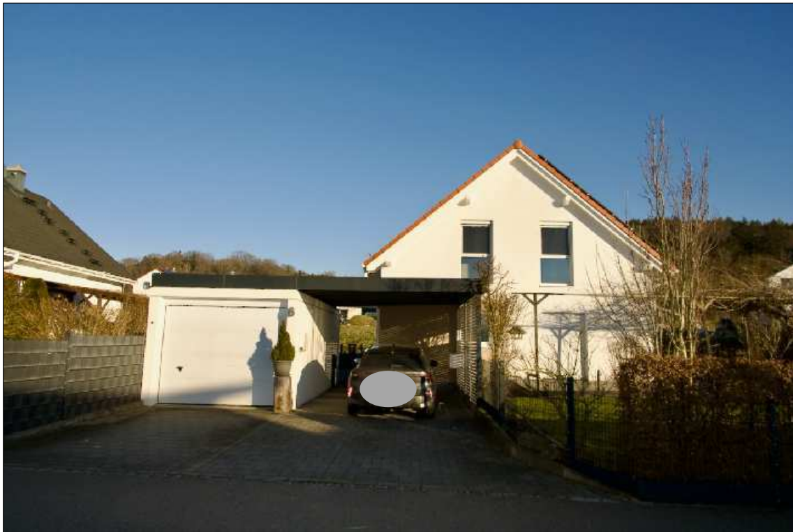
Foto 1 Straßenansicht von Westen
