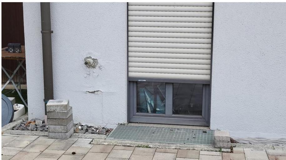
Ansicht von Süden, Feuchteschaden Gartenwasseranschluss
