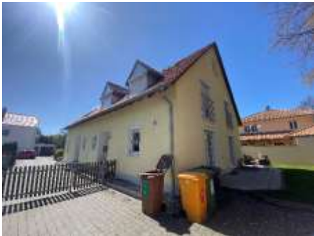
Bewertungsobjekt (Ansicht von Nordosten)
