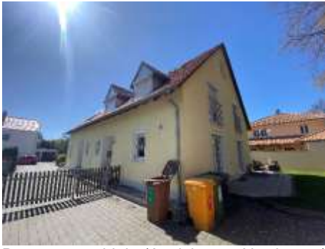
Bewertungsobjekt (Ansicht von Nordosten)
