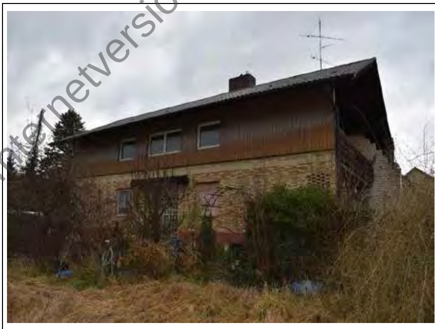
Foto 6: Ansicht von Südwest
