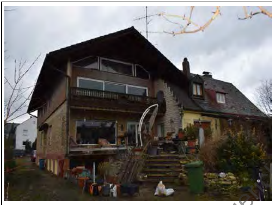
Foto 7: Ansicht von Süd
