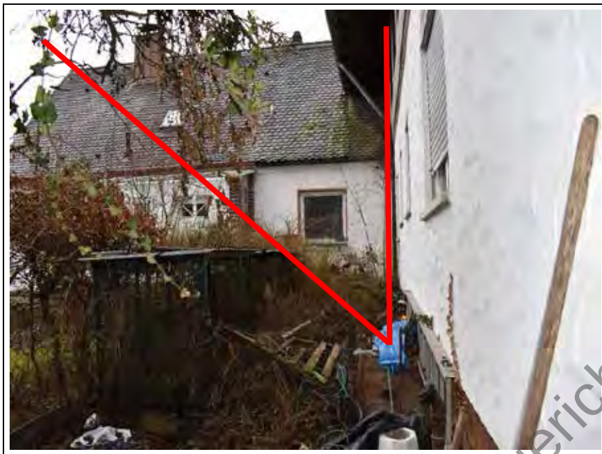
Foto 3: Ansicht von Nord, östl. Längsseite
