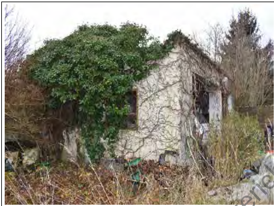
Foto 36: Garagengebäude, Blick von Nordost
