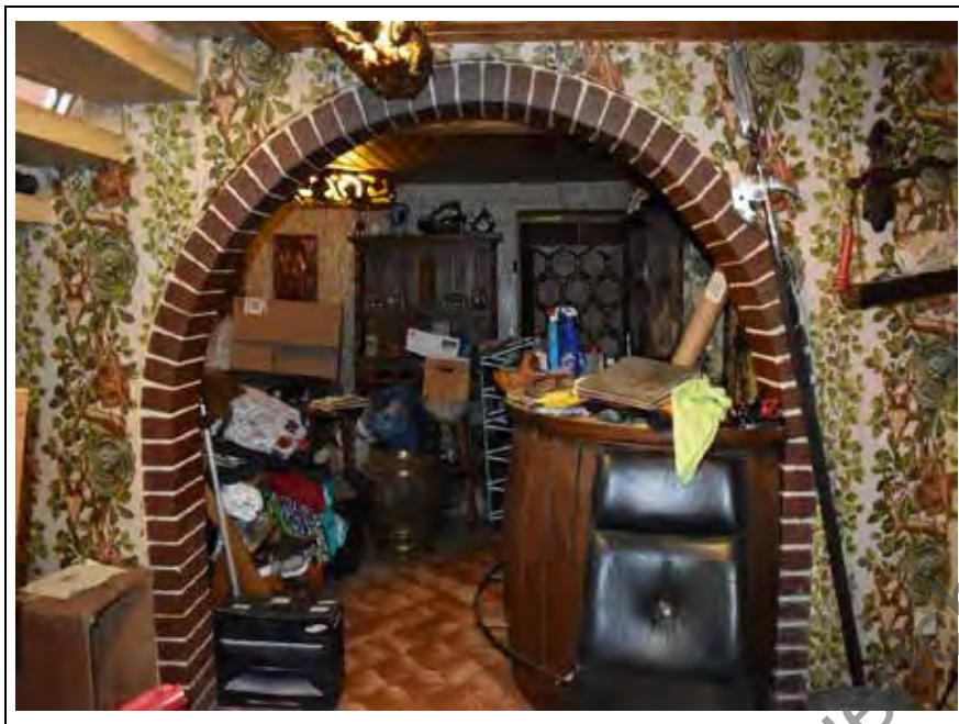
Foto 11: KG, Blick vom Treppenhaus zum Keller 1
