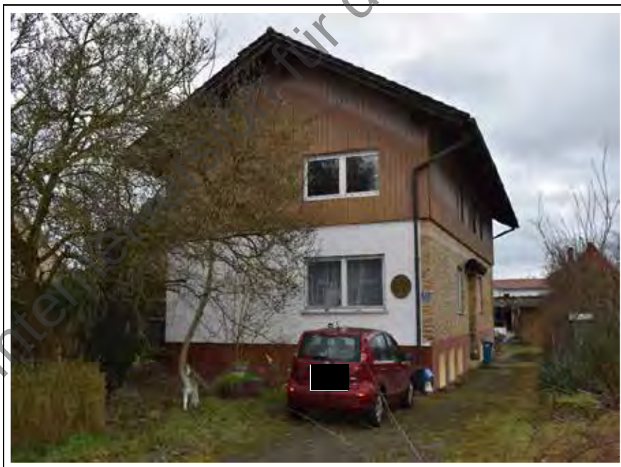
Foto 2: Ansicht von Nord
