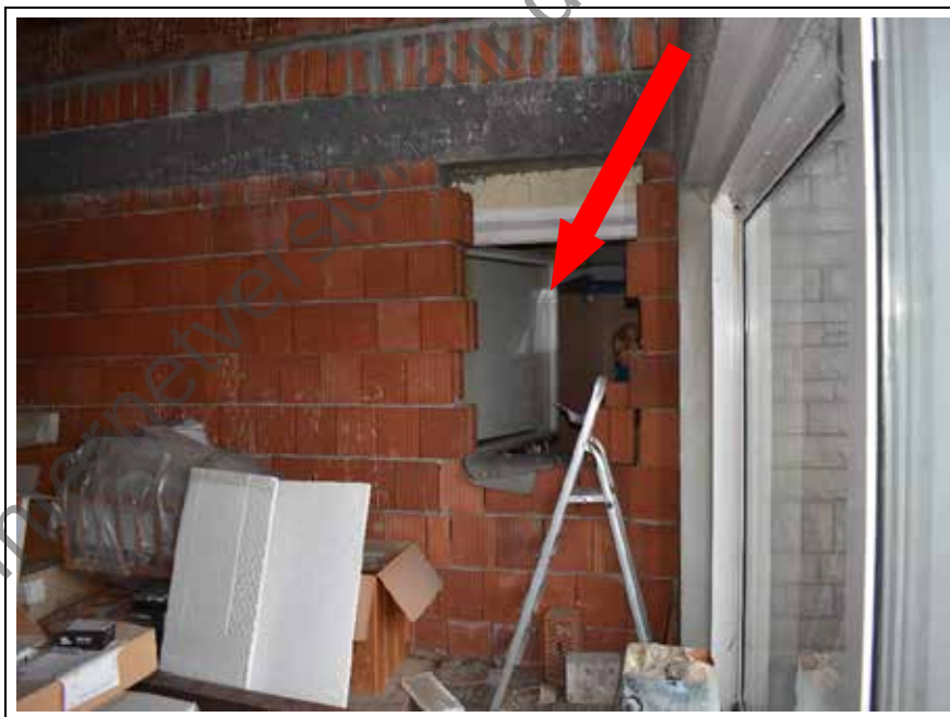
Foto 30: OG/DG, Anbau; einziger Zugang über Aussparung zum Gästezimmer
