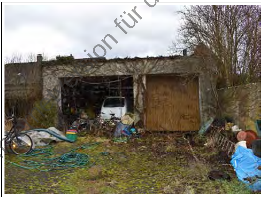
Foto 35: Garagengebäude, Blick von Nord
