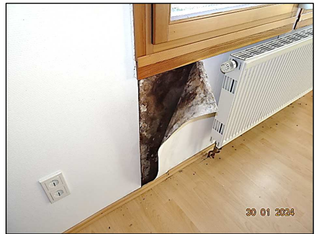
Arbeitszimmer DG – Feuchtigkeitsschaden Außenwand Westseite
