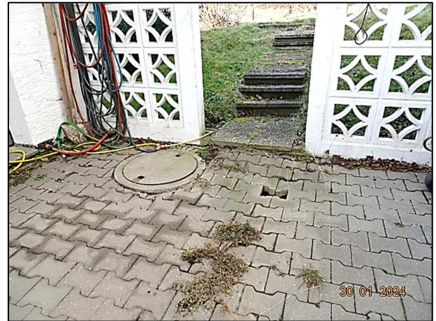
Betonpflaster Überdachung (mit Schäden)
