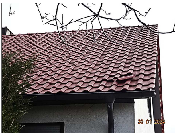
Erneuerte Dachdeckung – lose Platte
