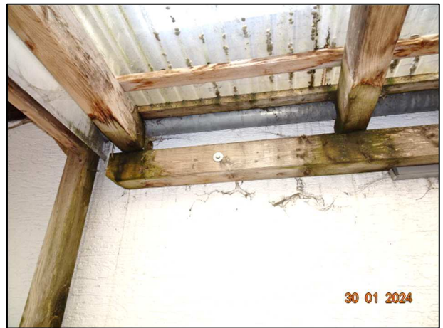
Feuchtigkeitsschäden bei Überdachung
