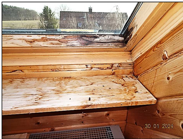
Dachflächenfenster mit Feuchtigkeitsschäden
