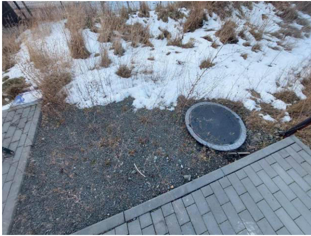
Deckel der Regenwasserzisterne und geschotterter Gehweg
