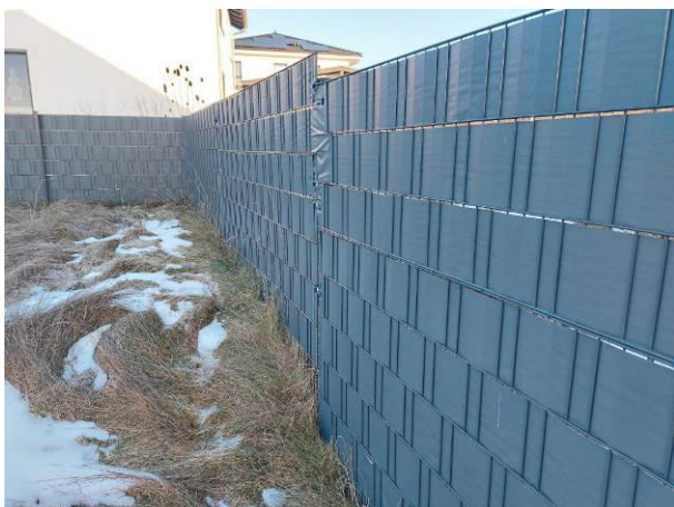
Einfriedung mit Doppelstabmattenzaun und Sichtschutzstreifen
