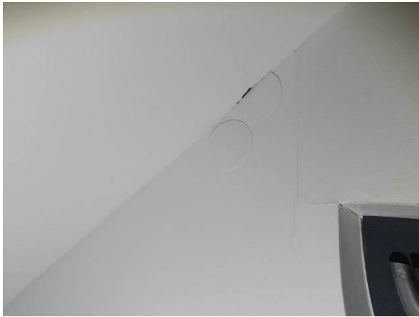
Spannungsrisse
