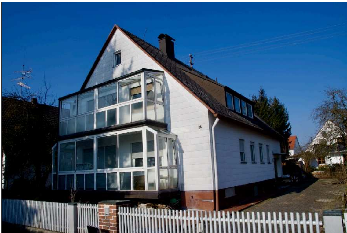
Foto 2 Straßenansicht von Süden
