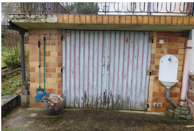
Zugang Raum unter Terrasse, Zustand
