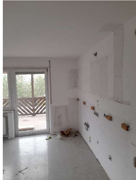
OG – Küche mit Tür zum Balkon
