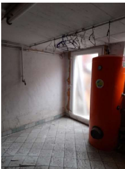
KG – Waschküche mit unverputzter Kellerabgangstür
