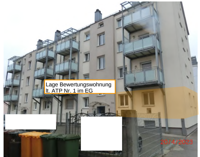
NW-Fassade und Hauseingangsseite , Lage Bewertungswohnung im EG (Markierung) ...
