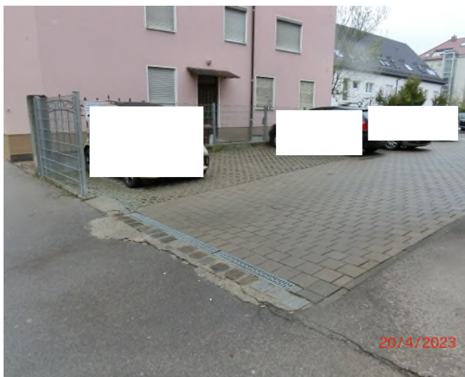
... im nordwestlichen Grundstücksbereich befindlicher, befestigter Kfz-Abstellplatz
