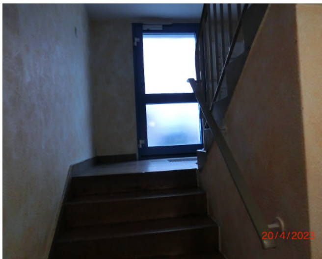
Treppenhaus - vom KG zum Hauseingangsbereich führender Treppenlauf
