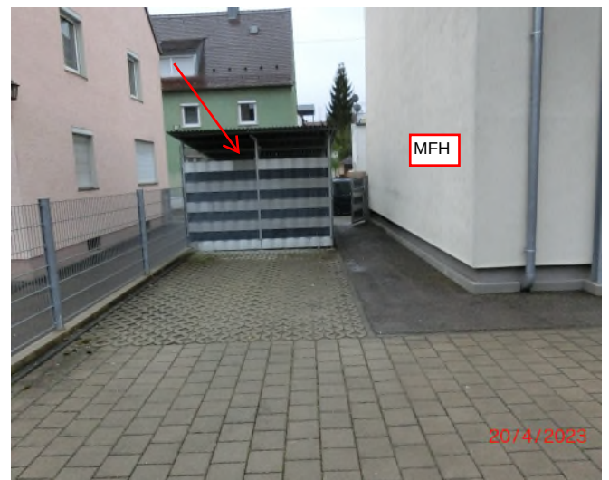
Nebengebäude an der Grundstücksgrenze NO
