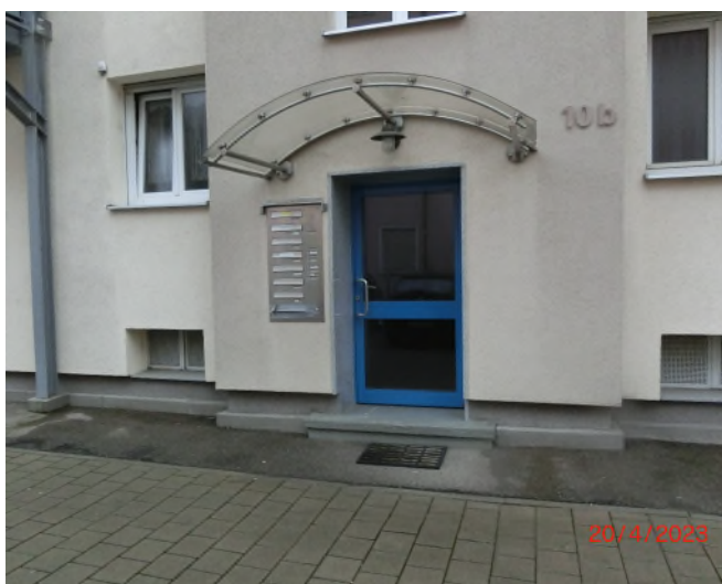
Hauseingang "Aufgang B"
