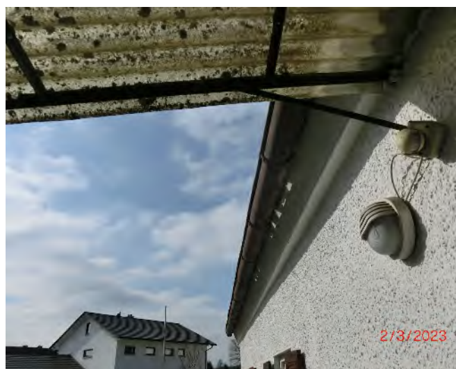
... und an Hauseingangssituation - hier Überdachung und Außenbeleuchtung
