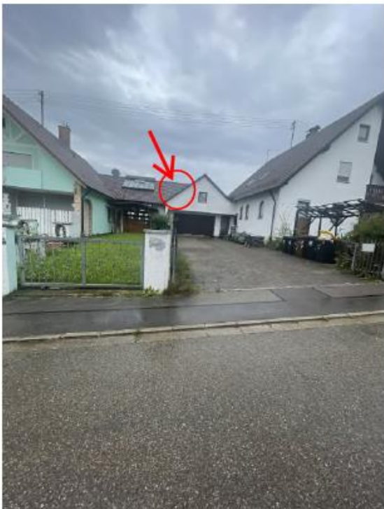
SW Ansicht - Hofeinfahrt, Überbau markiert
