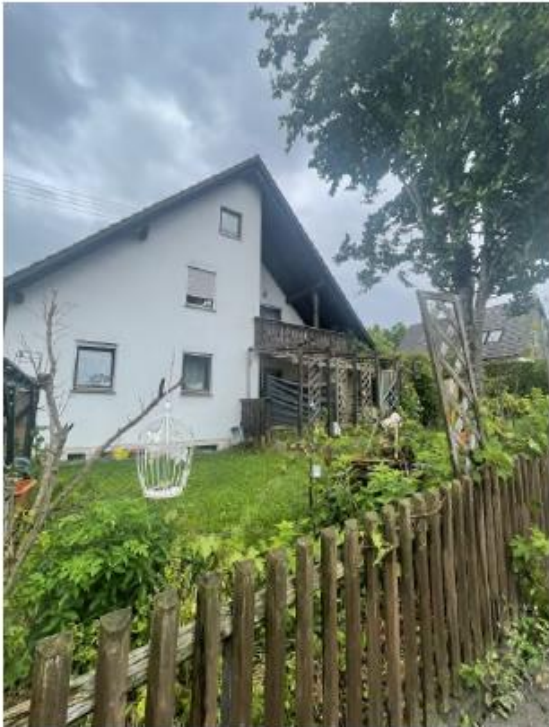
Blick auf SW Fassade des Bewertungsobjektes
