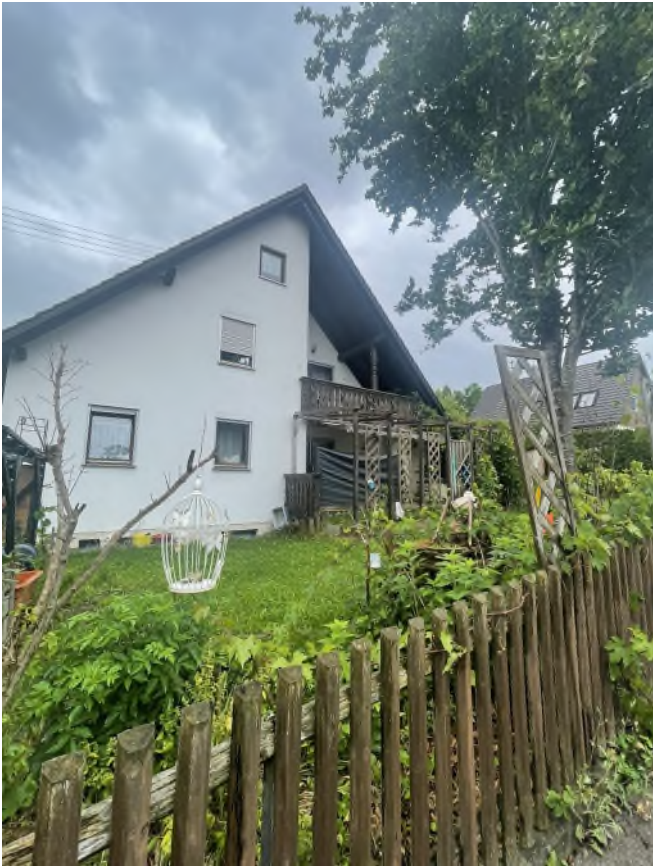
Blick auf SW Fassade des Bewertungsobjektes
