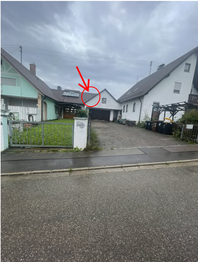
SW Ansicht - Hofeinfahrt, Überbau markiert
