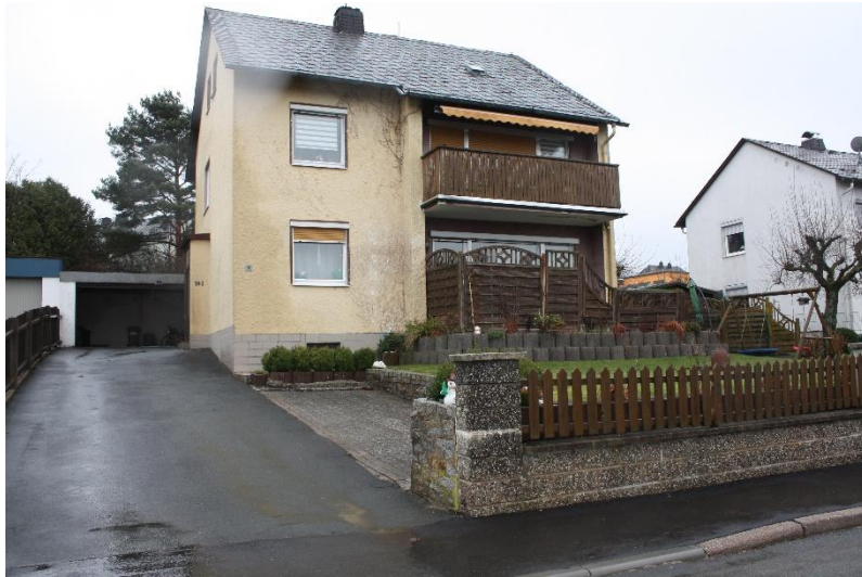
Blick auf das Gebäude von der Oderstraße aus, links die Zufahrt zu der Doppelgarage, vor dem Gebäude rechts der PKW-Abstellplatz
