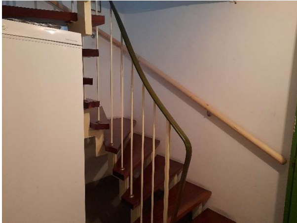
KG – Kellertreppe zum Erdgeschoss
