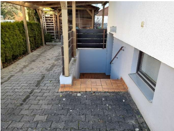
Kellerabgang zur Praxis - Nordseite
