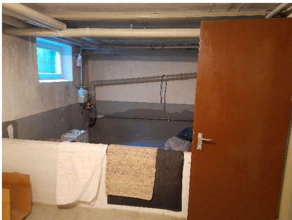
KG – Waschküche mit ehemaligen Öl-Tank-Lager
