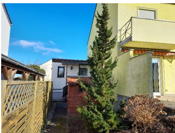
Wohnhaus – Südwestansicht Anbau
