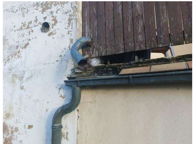
schadhafte Regenfallrohre
