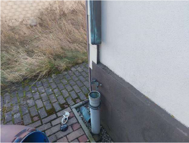
schadhafte Regenfallrohre
