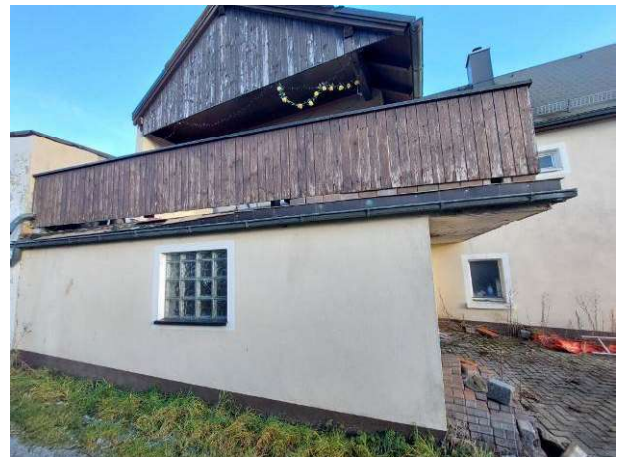
verwitterte Holzbauteile
