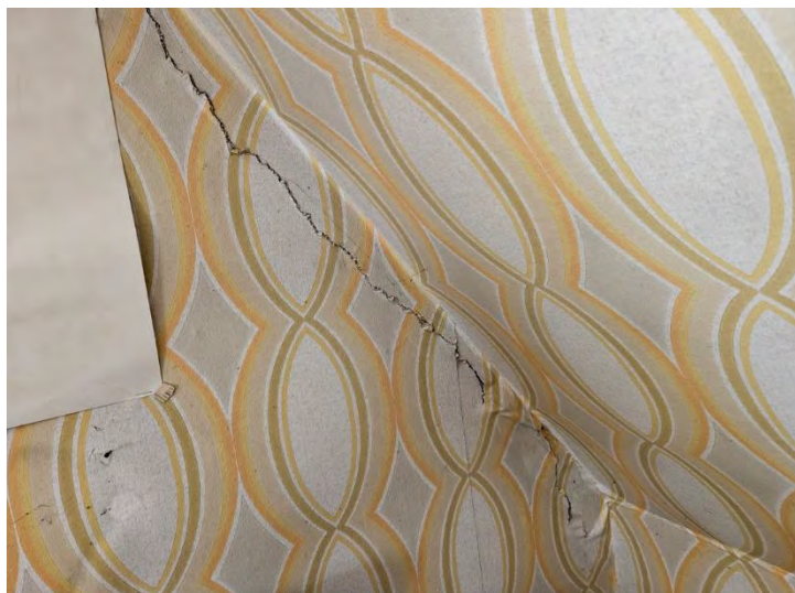
Riss im Übergangsbereich Giebel/Ortgang - exemplarisch
