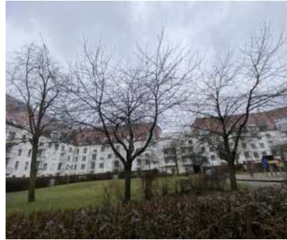
rückwärtige Ansicht Wohnanlage, Blickrichtung Südwesten
