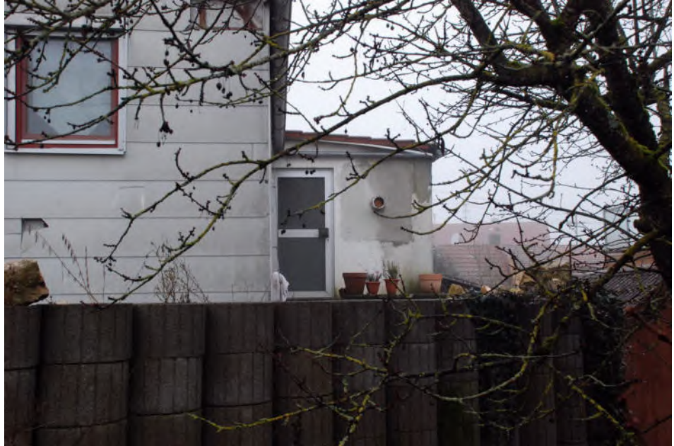
Ostseite des Geräteraums
