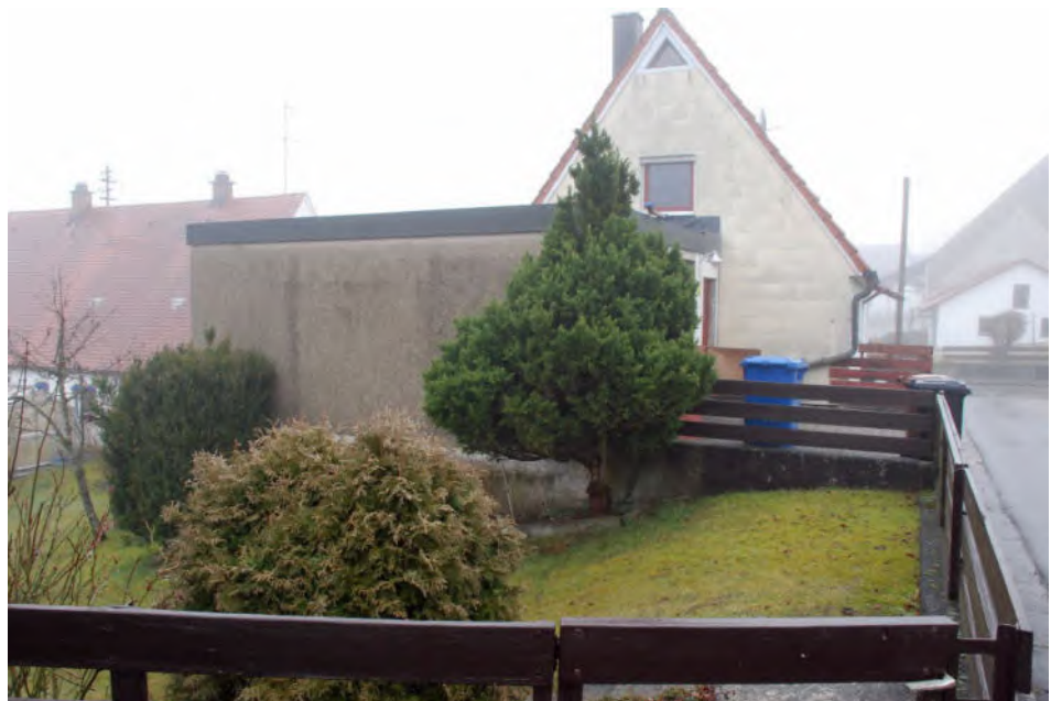
Westseite der Garage
