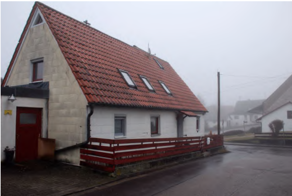
Südseite und Westgiebel des Wohnhauses
