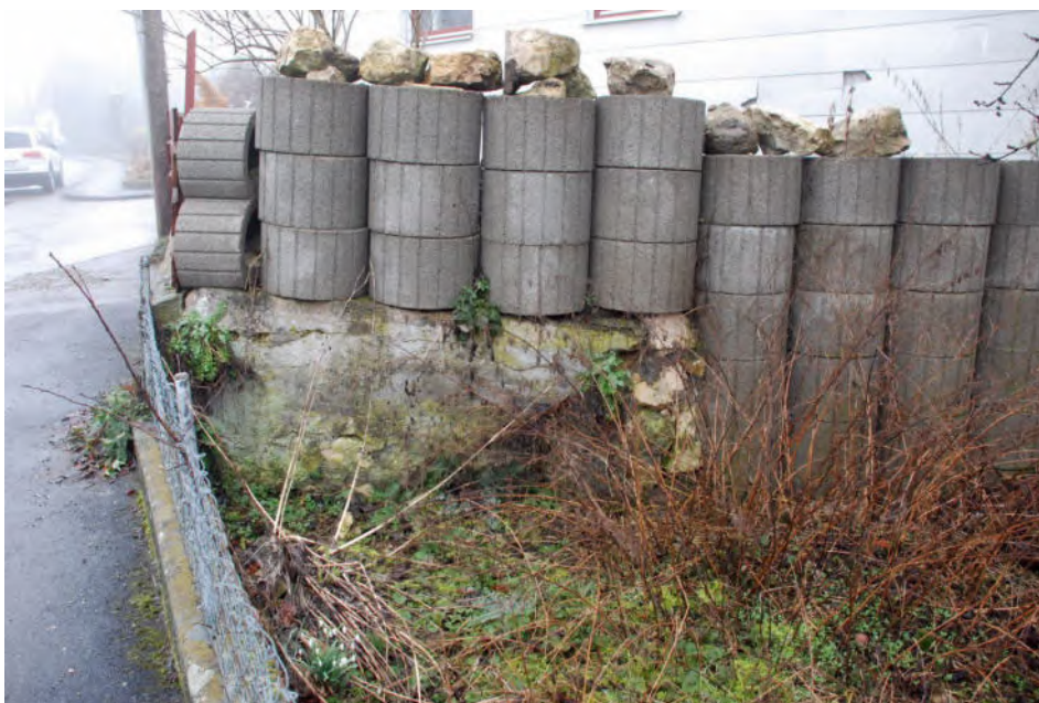
Nordöstliche Grundstücksabfangung mit Betonformsteinen
