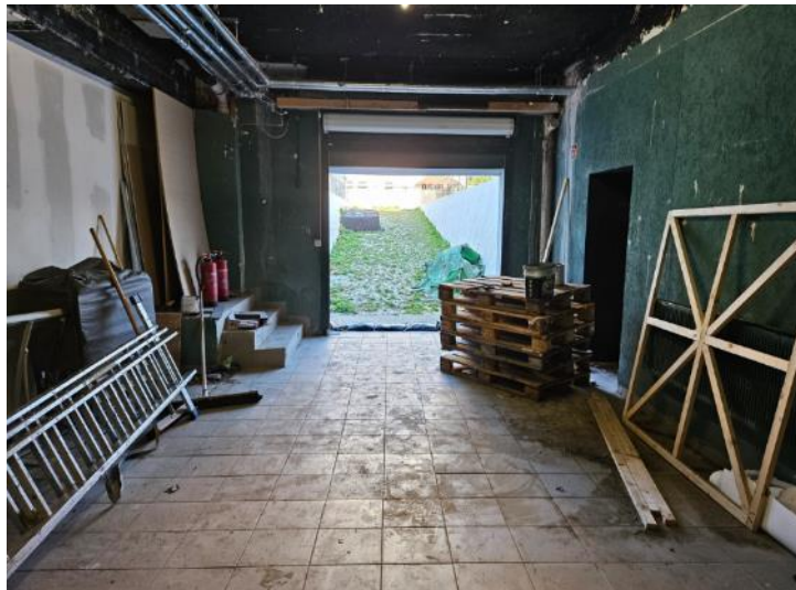
Zugangsbereich über Rampe (Ostseite) in das UG
