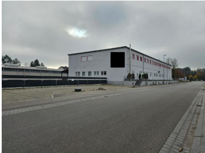
Ansicht Nord-Ost mit anliegender Straße
