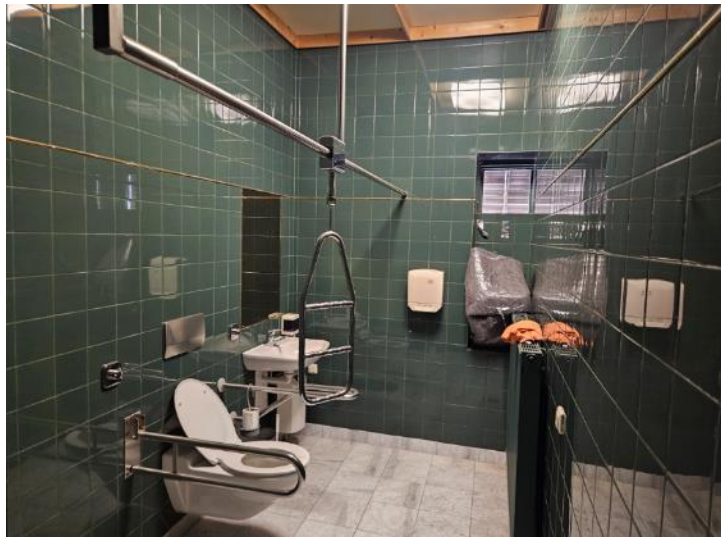
Sanitärbereiche ehem. Spielothek (EG) – exemplarisch
