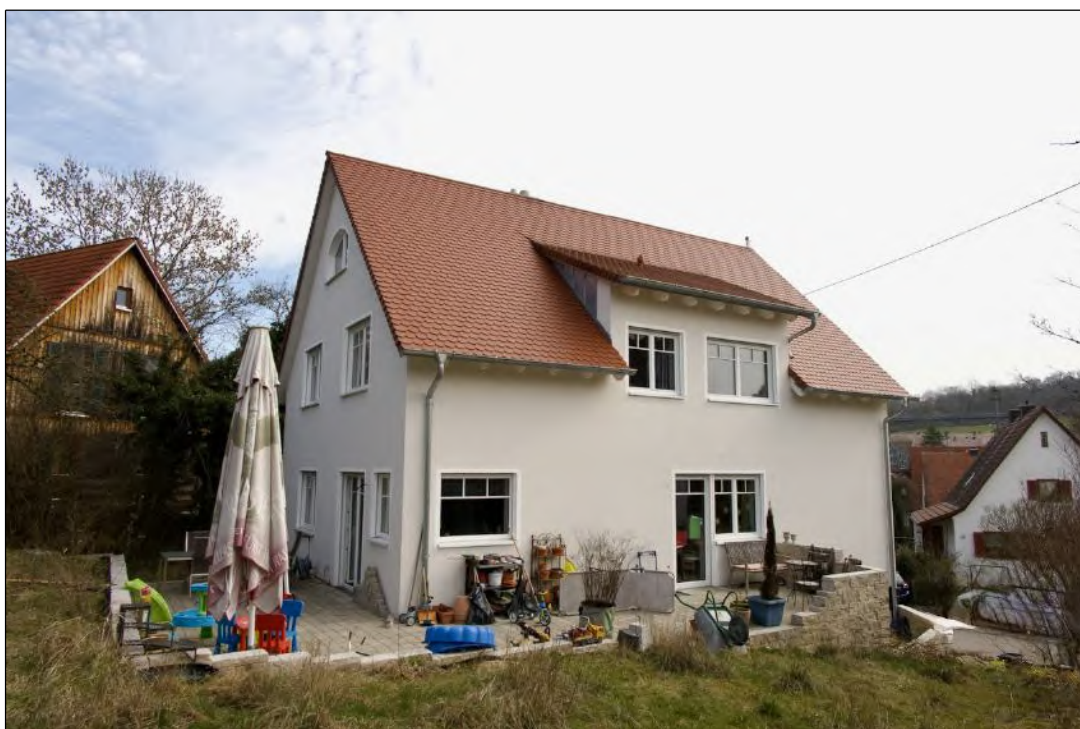
Foto 2 Ansicht von Süden
