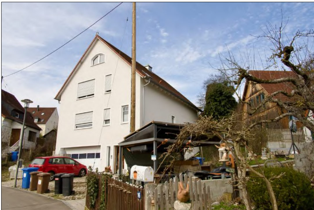
Foto 4 Ansicht von Nord-Osten
