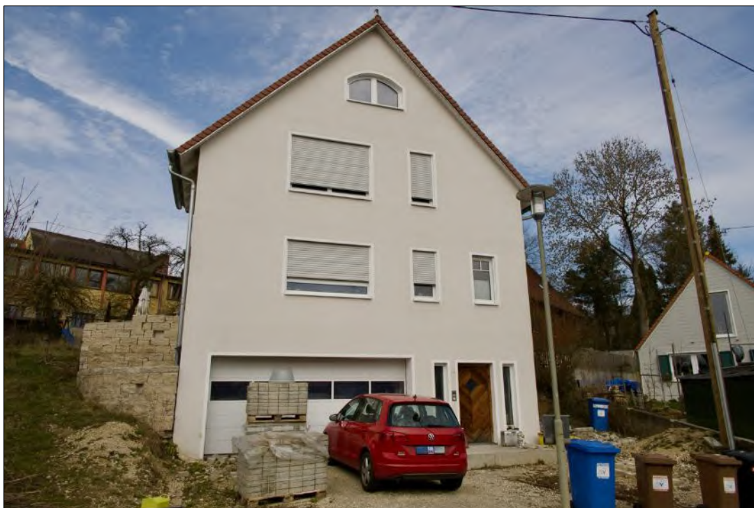
Foto 1 Straßenansicht von Osten
