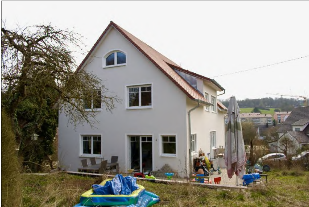
Foto 3 Ansicht von Westen
