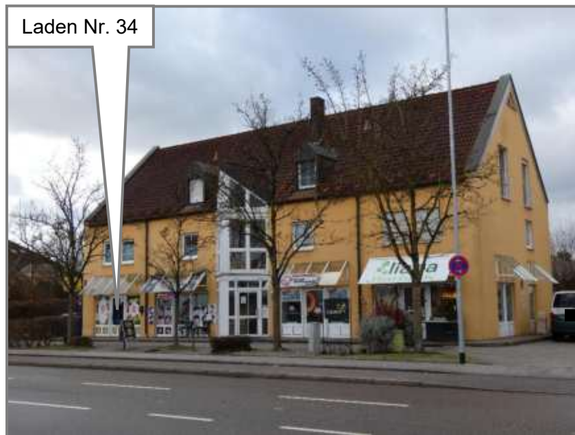
Wohn- und Geschäftshaus Hausnummer 19 - Ansicht von Osten
