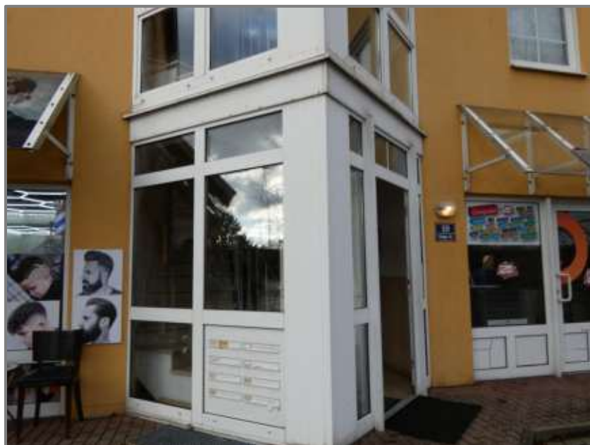
Hauseingang Hausnummer 19 an der Ostfassade
