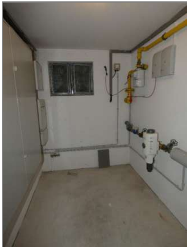
Kellergeschoss - Hausanschluss
