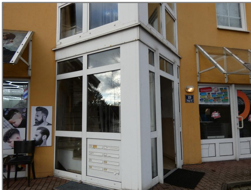
Hauseingang Hausnummer 19 an der Ostfassade
