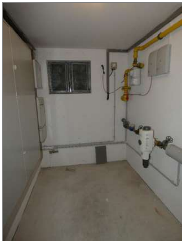
Kellergeschoss - Hausanschluss
