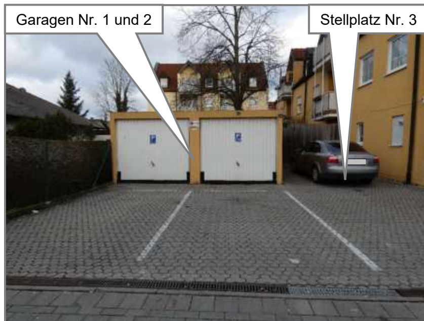
südlicher Grundstücksbereich mit dem alleinigen Sondernutzungsrecht an den Garagen Nr. 1 und 2 sowie dem Pkw-Stellplatz Nr. 3
