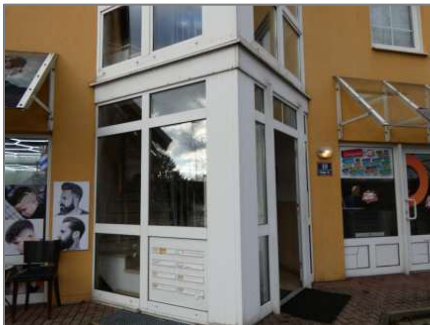
Hauseingang Hausnummer 19 an der Ostfassade
