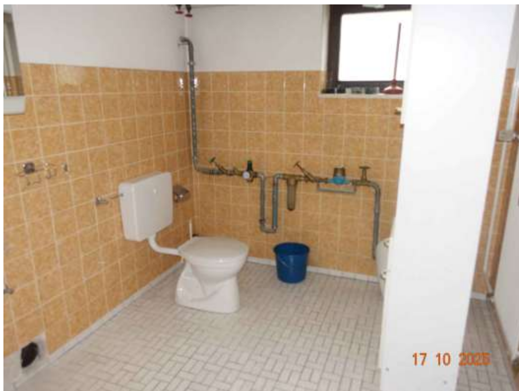
Abbildung 16: Kellerraum mit Stand-WC und Dusche
