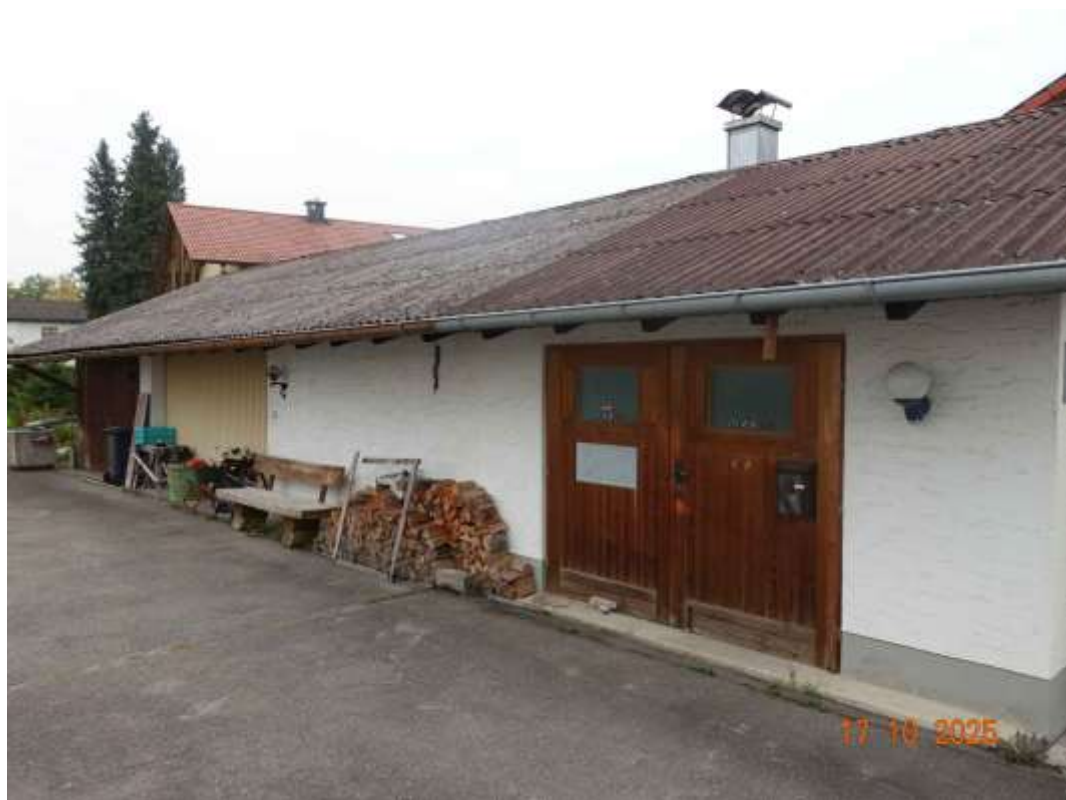
Abbildung 4: Werkstattgebäude entlang der westlichen Grundstücksgrenze
