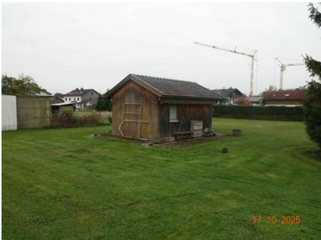
Abbildung 6: Holzschuppen auf der südlichen Grundstücksfläche (Sollgrundstück B)
