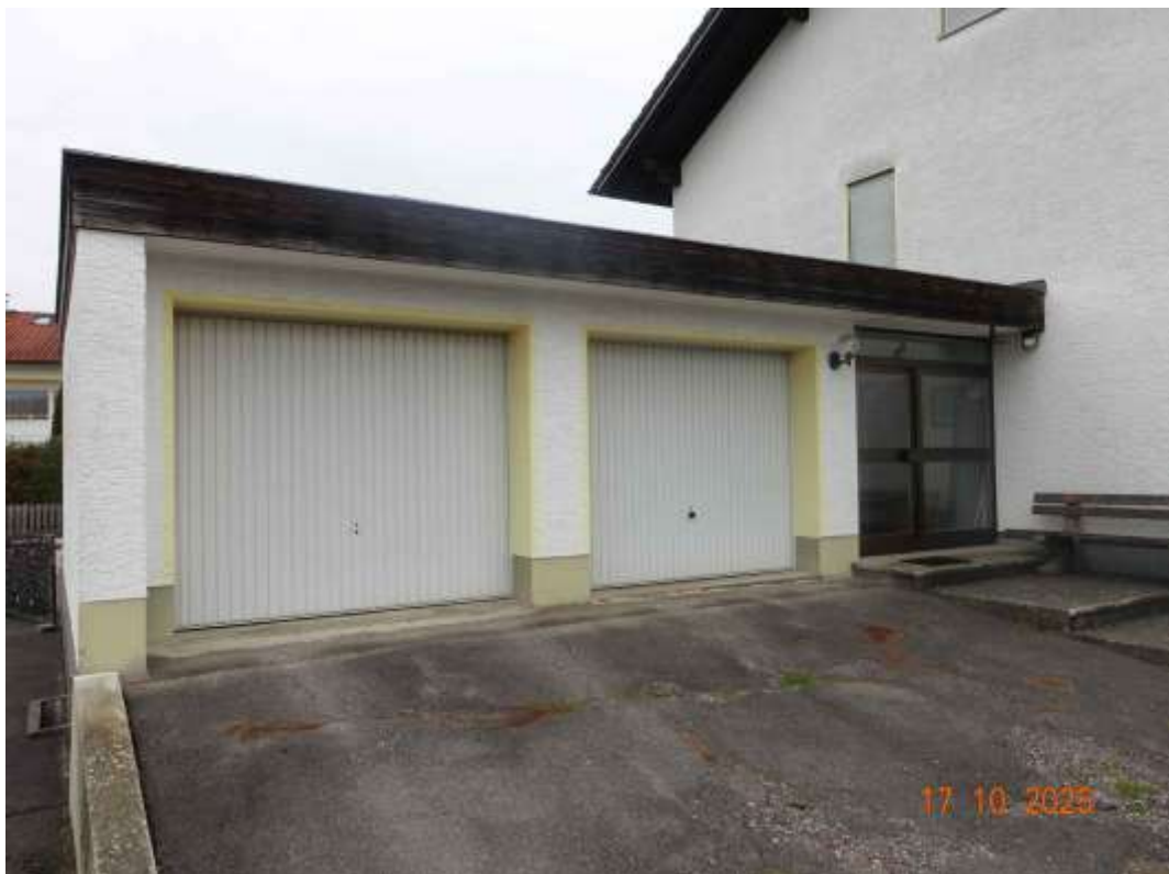
Abbildung 8: Doppelgarage mit Zwischenbau als Zugang zum Wohnhaus und Garagen
