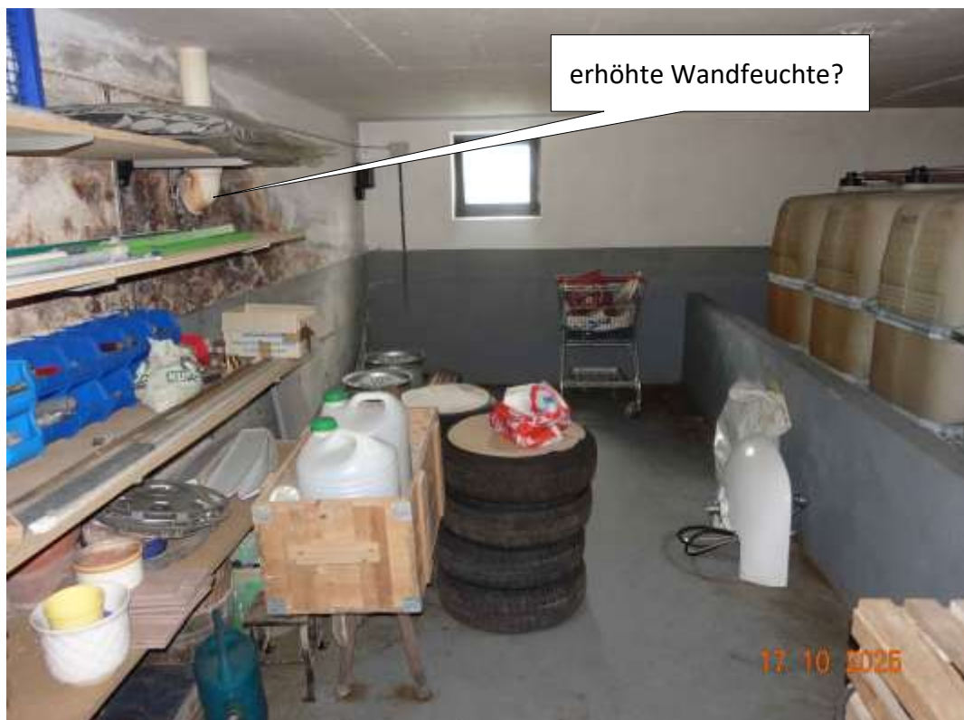
Abbildung 12: Heizöllagererraum mit 5 Kunststofftanks (jeweils 2000l)
