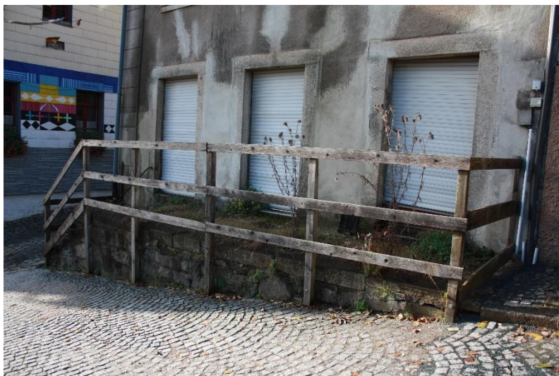
der provisorische Hauszugang entlang des Gehweges in Verlängerung der Ludwigstraße, rechts im Foto die frühere Eingangstüre des Ladens
