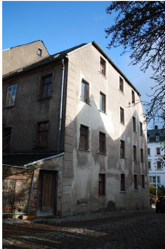
der Südgiebel mit Krüppelwalm des Hauses an der Kirchgasse
