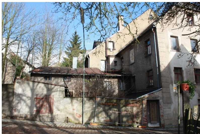
Blick auf das Nebengebäude von der Kirchgasse aus gesehen
