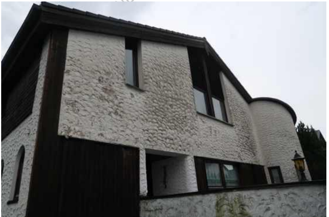
Fassadenzustand im Nordwesten
