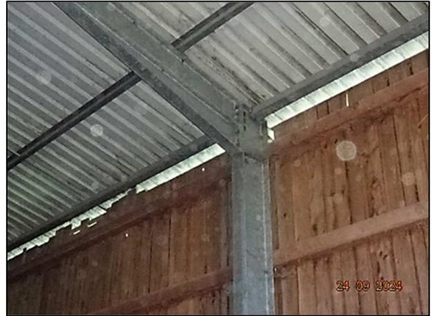
Lagerhalle A – verzinkte Stahlkonstruktion
