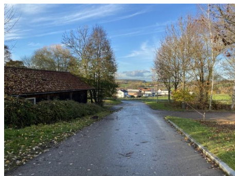
Erschließungsstraße – Blickrichtung Norden
