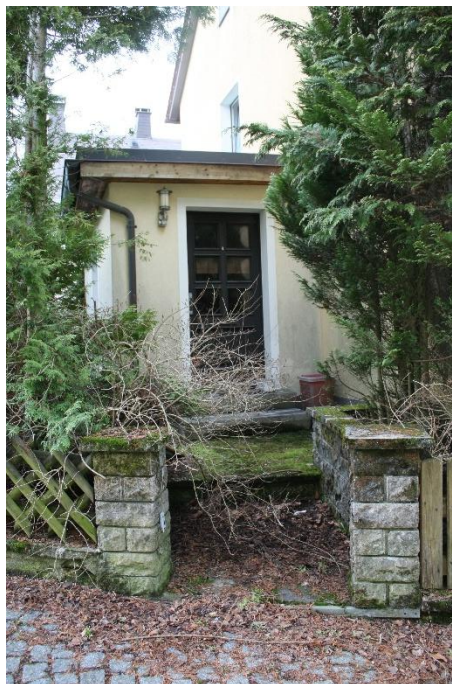
das Vorhaus mit der Eingangssituation am Kirchplatz (s. Pfeil im Lageplan)
