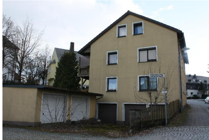
An der Nordseite des Zweifamilienwohnhauses sind im Kellergeschoss noch drei Garagen angeordnet.
