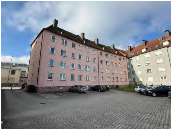
Bewertungsobjekt, Ansicht von Nordosten
