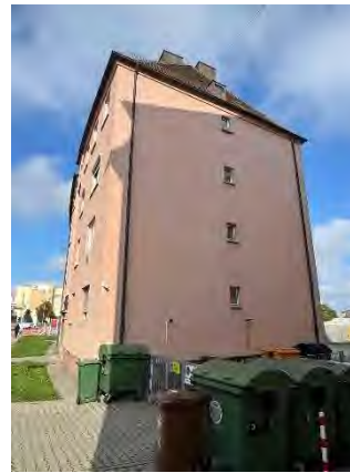
Bewertungsobjekt, Ansicht von Osten
