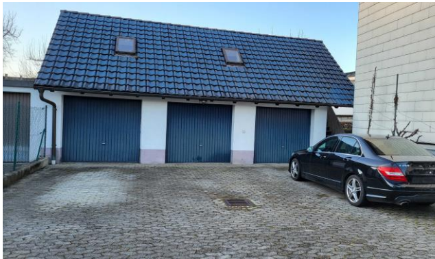
Reihengarage, Ansicht vom Südosten
