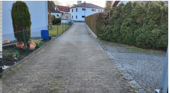
Zufahrt, belastet mit Geh- u. Fahrtrechten
