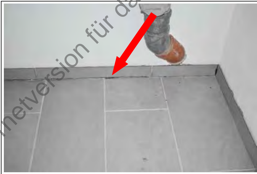
Foto 17: KG, Keller 3, offene Fugen
