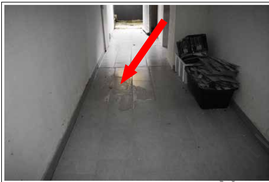
Foto 10: KG, Flur mit unebenem Bodenbelag und Pfützenbildung
