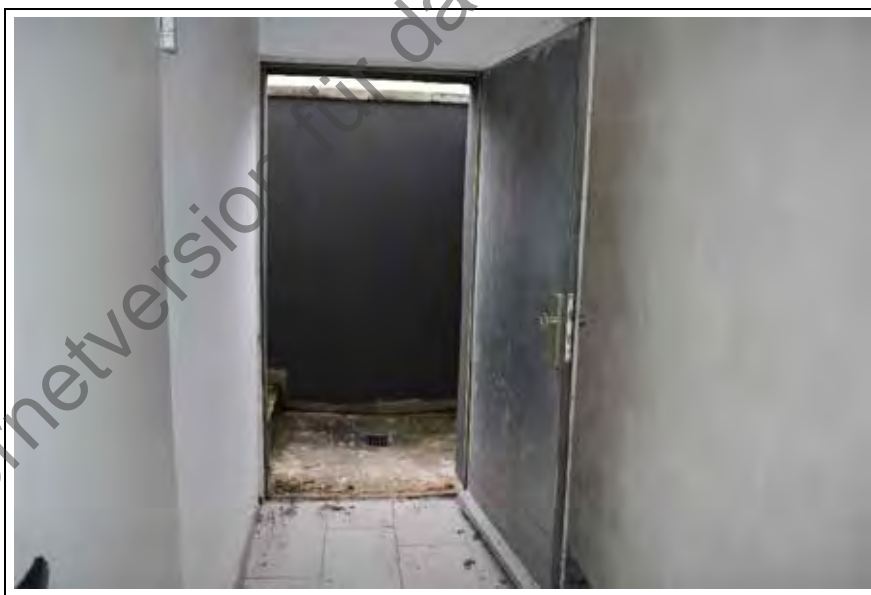
Foto 11: KG, Flur mit außenliegendem Kellerabgang
