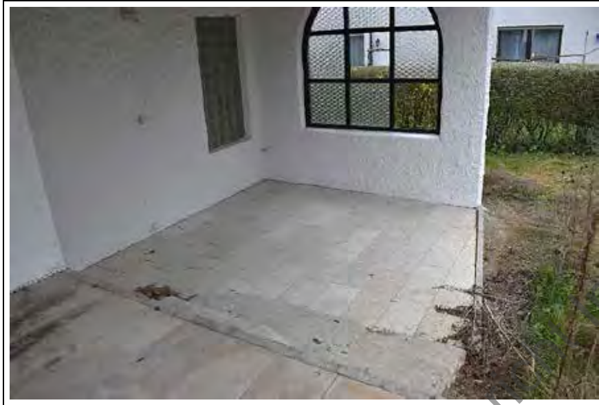
Foto 48: Terrasse 1 (Bereich Garage)
