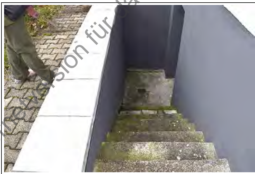
Foto 51: außen liegender Kellerabgang
