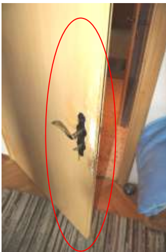
Abb. 32: Whg. I. OG re. – Gebrauchsspuren beispielhaft
