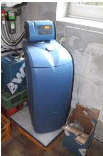
Abb. 19: KG - Wasserenthärtungsanlage
