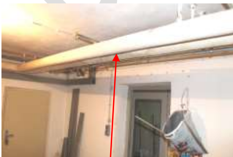
Abb. 20: KG - Zementschlammisolierungen beispielhaft
