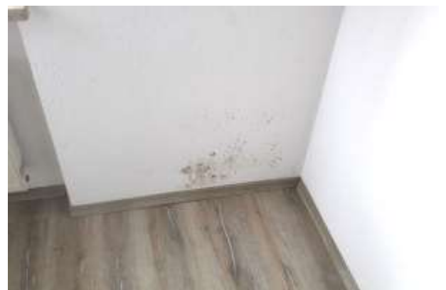
Abb. 23: Whg. I. OG li. – alte Pilzflecken, beispielhaft
