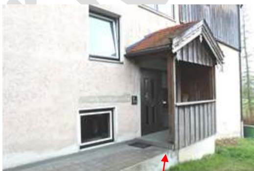
Abb. 8: Nordseite - Hauseingang, fehlende Absturzsicherung
