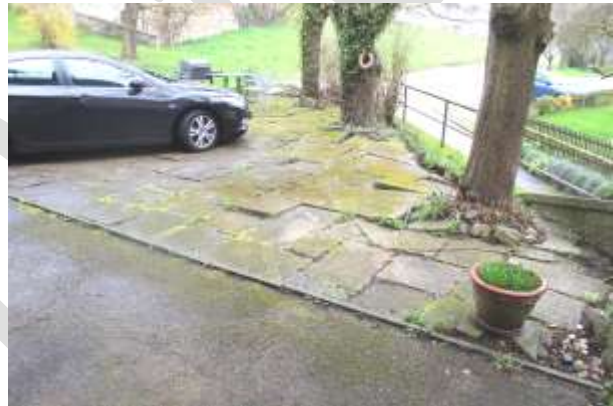
Abb. 10: Südosten - schadhafter Plattenbelag
