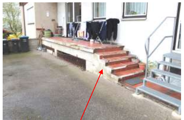
Abb. 11: Südosten – Rampe schadhaft, fehlende Absturzsicherung
