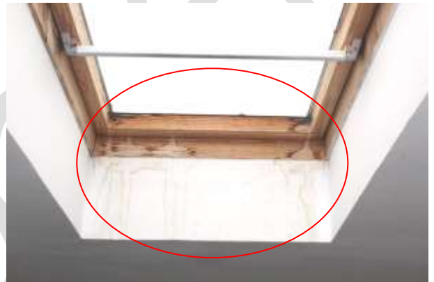
Abb. 35: DG - Treppenhaus – Dachflächenfenster Wasserspuren
