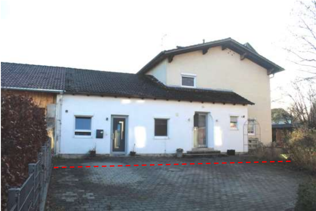
Abb. 1: Westansicht Wohnhaus mit Anbau und Teilbereich der Hoffläche
