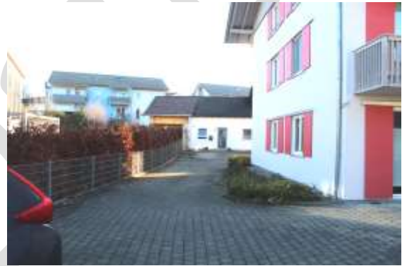
Abb. 17: Zufahrt über Nachbargrundstück, Umgebungsbebauung (beispielhaft)
