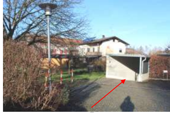
Abb. 19: Tiefgaragenabfahrt des östlichen Nachbarn
