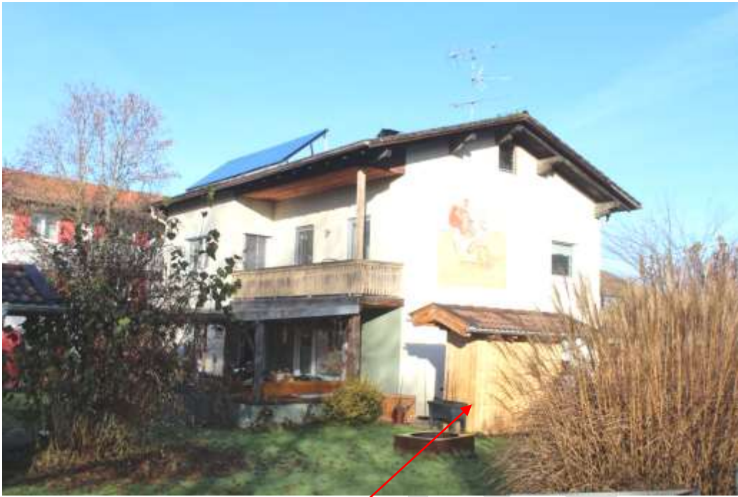
Abb. 5: Südostansicht Wohnhaus, kleine Holzlege
