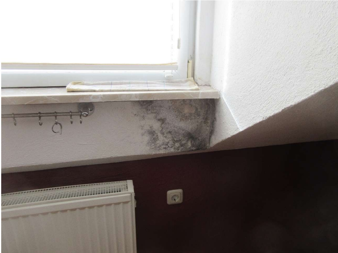
Foto 9: Schwärzepilz an den Gauben innenseitig (beispielhaft)
