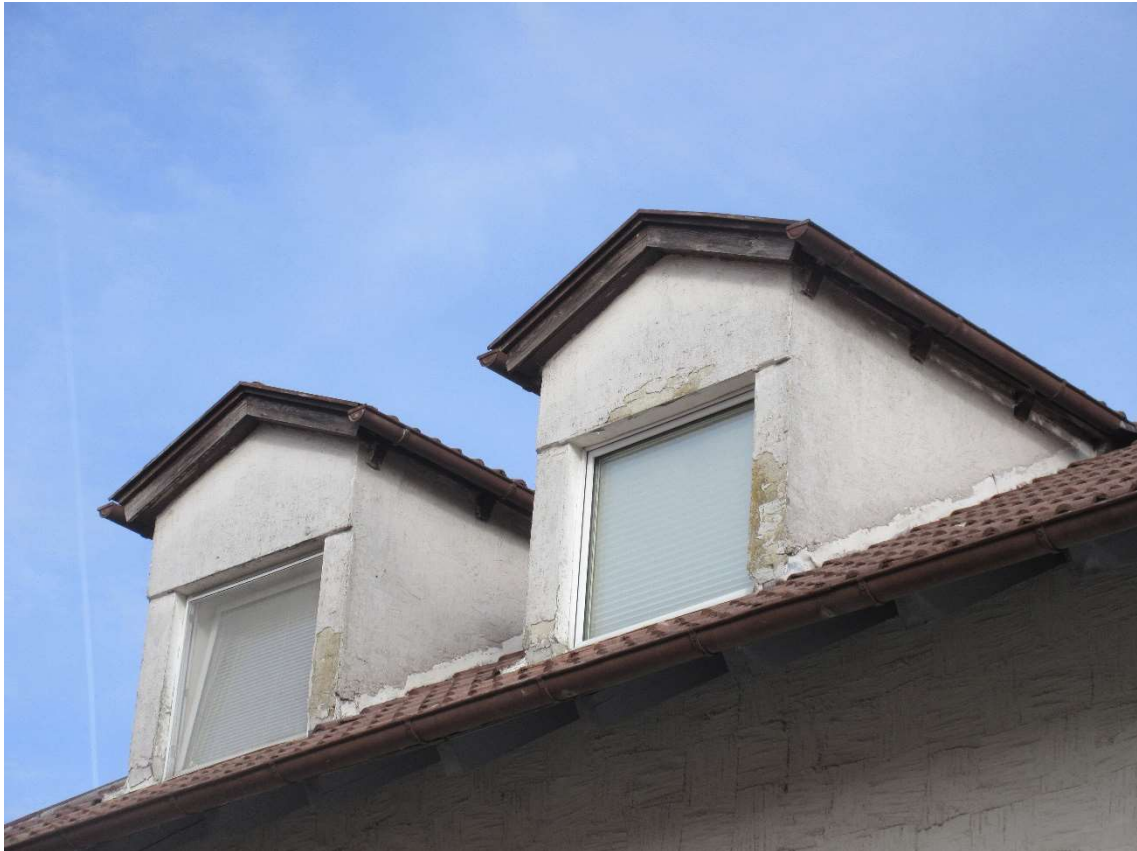
Foto 7: Putzschäden an den Gauben (beispielhaft)
