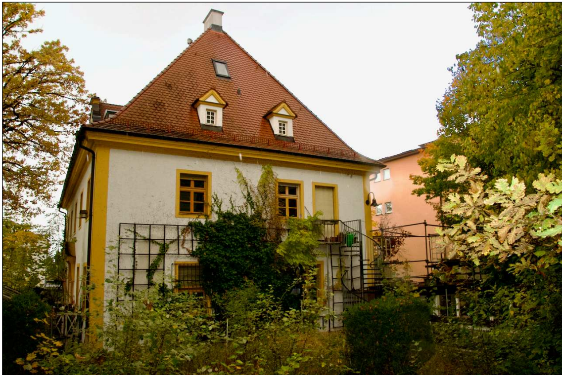
Foto 2 Ansicht von Osten
