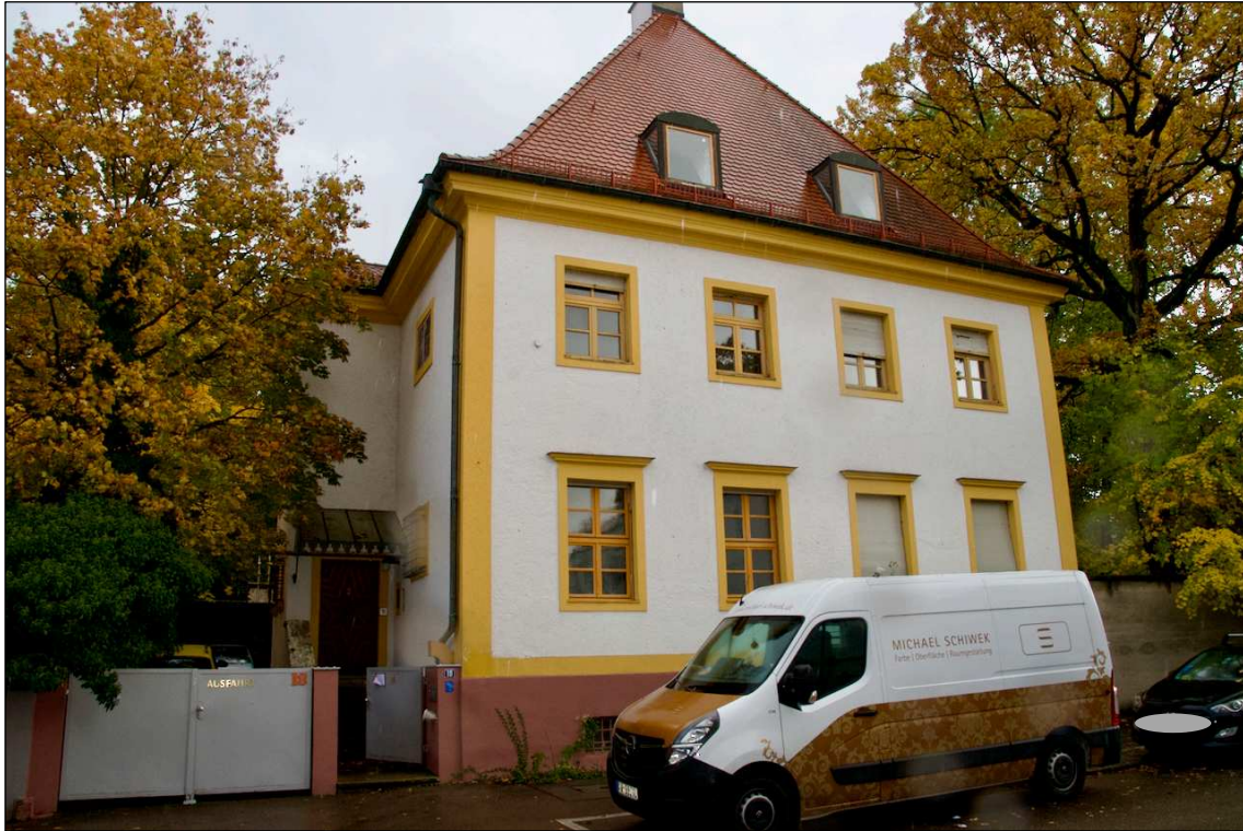
Foto 1 Straßenansicht von Westen
