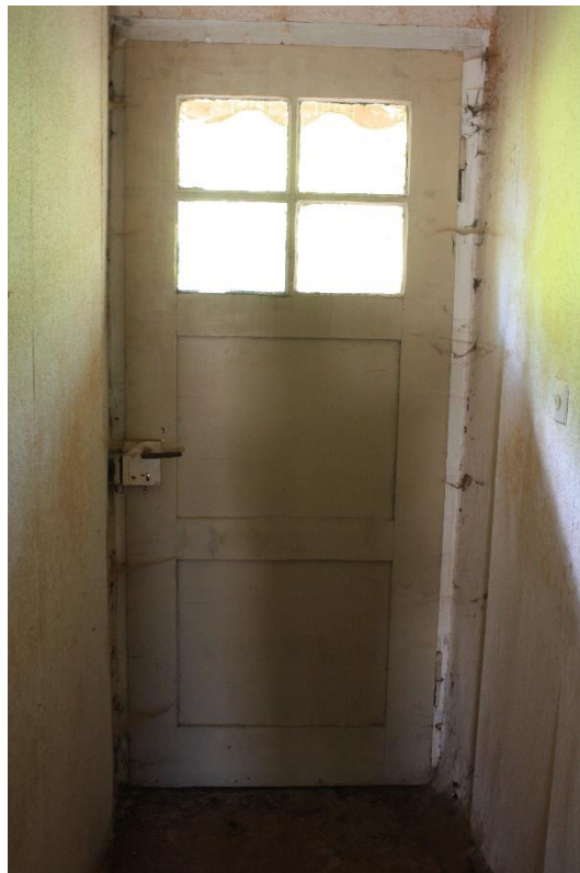
Über diese Türe im Obergeschoss gelangt man zum Hauseingang des Gebäudes Flur-Nr. 470.
