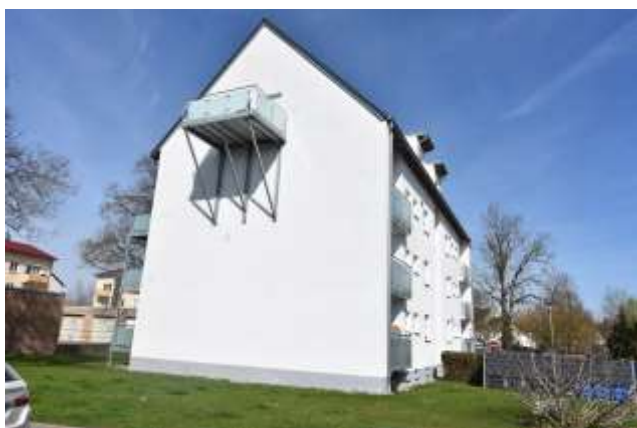
Ansicht von Südosten, Balkon Südseite zu Wohnung Nr. 19
