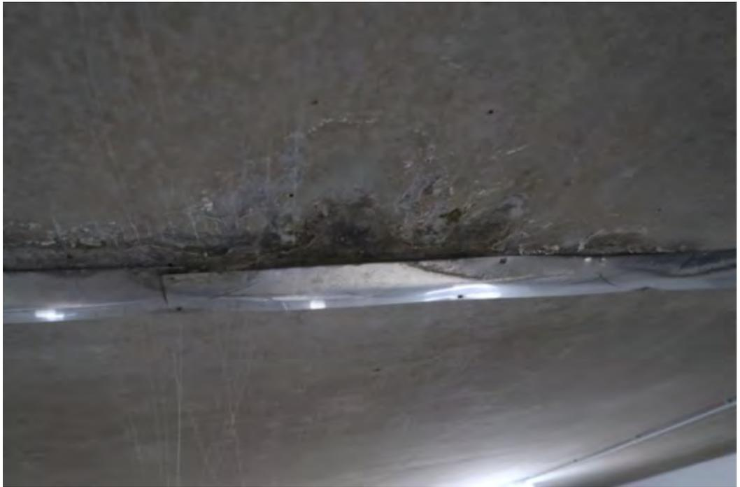
Provisorisch behobene Abdeckung eines Deckenrisses
