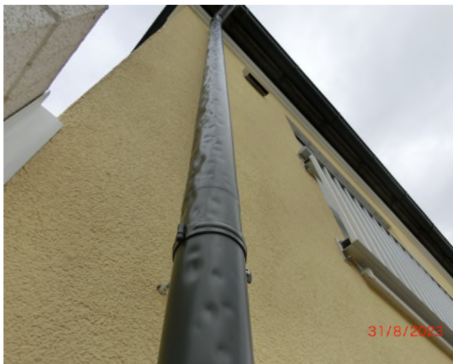
Eindruck Hagelschaden an der WH-Außenfassade
