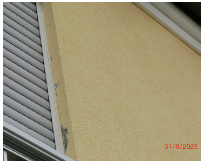
Eindruck Hagelschaden an der WH-Außenfassade
