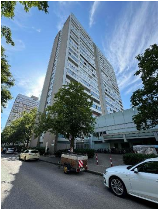
Gebäudeansicht von Nordwesten
