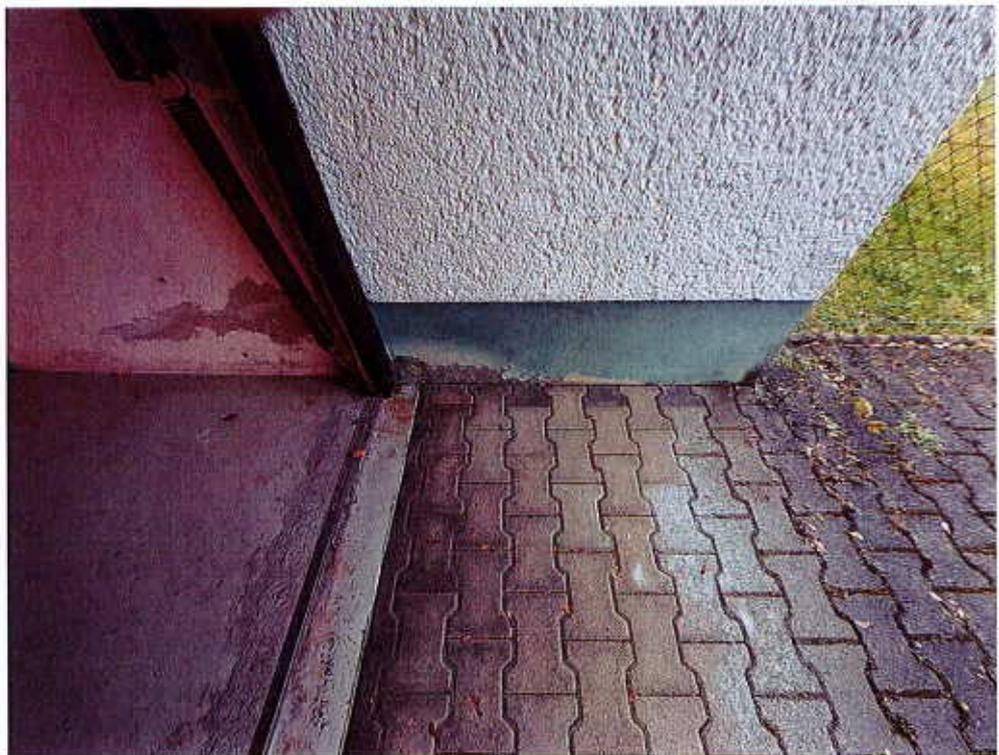
**Ausblühungen und Korrosionsschäden Garage**
