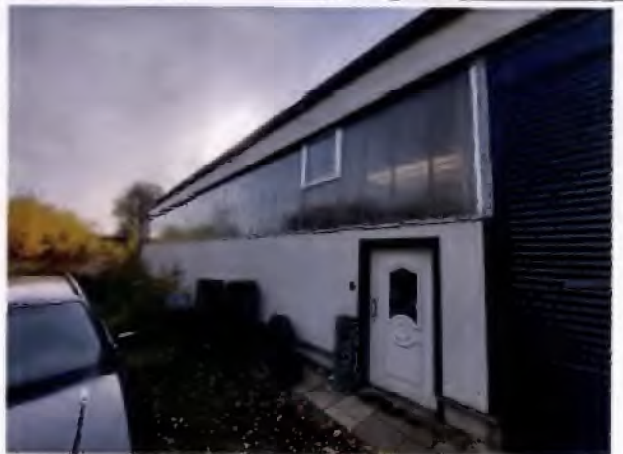
Rolltor und Zugang zur (6) Kaltlagerhalle 3
