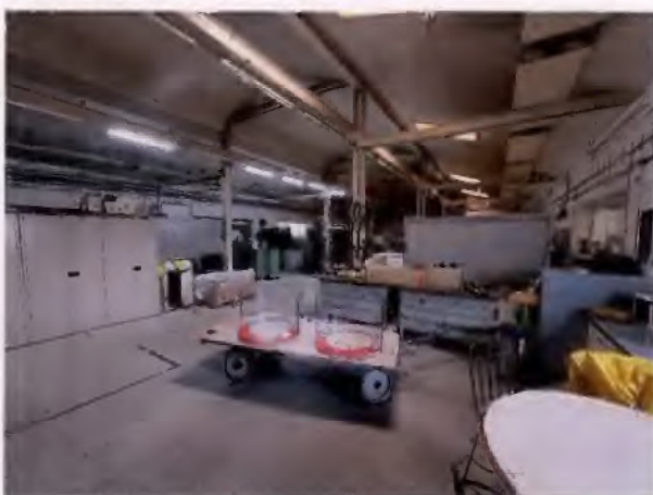
(4) Werkstatthalle 1 Halle mit Kranbahn
