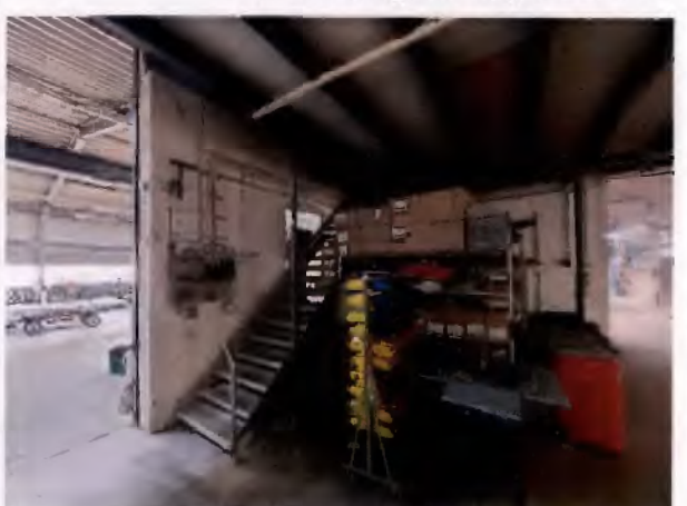
(4) Werkstatthalle 2 Stahlwagentreppe zum OG
