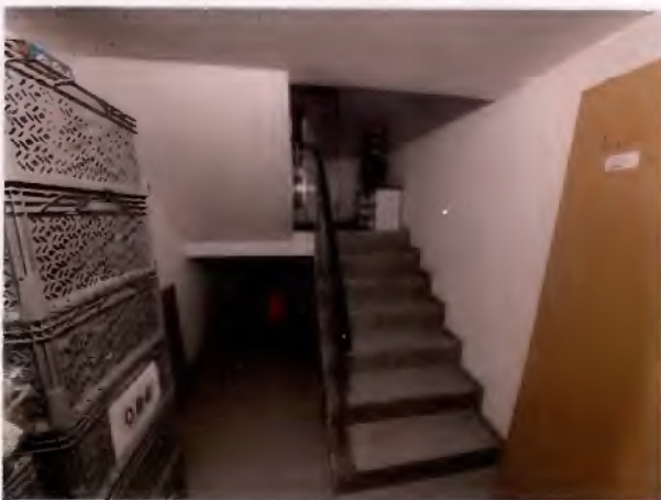
(2) Bürogebäude mit Wohneinheit KG – Treppenhaus
