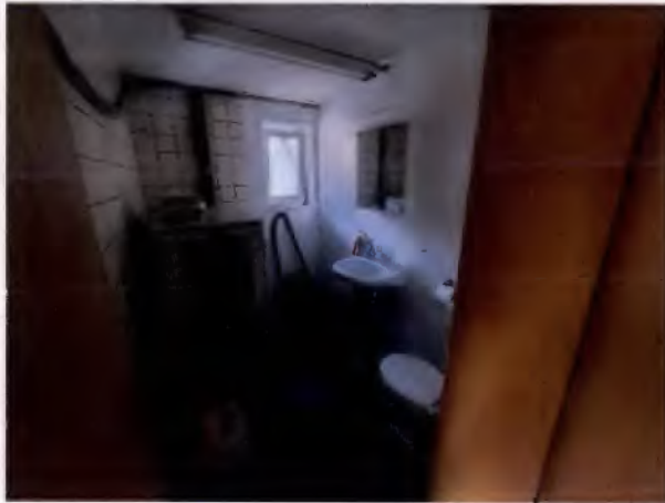
(2) Bürogebäude mit Wohneinheit EG – Damen-WC
