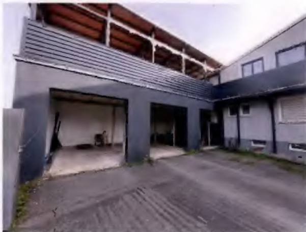
(3) Garage 3 Garagen / überdachte Dachterrasse mit Zugang
