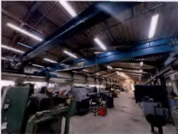
(1) Maschinen- / Lagerhalle 2 Kranbahnen (8,0 to. / 3,5 to.)
