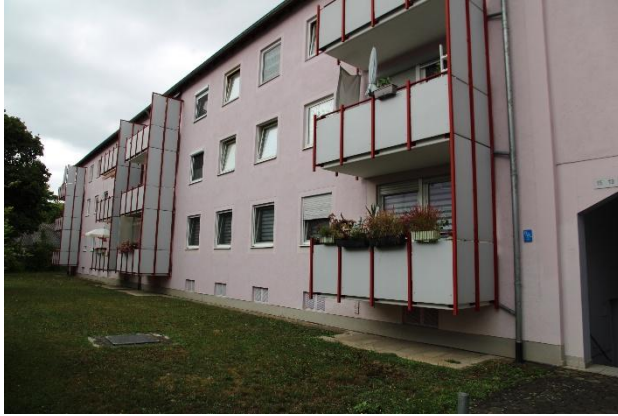
Außenansicht: Mehrfamilienhaus von Süden
